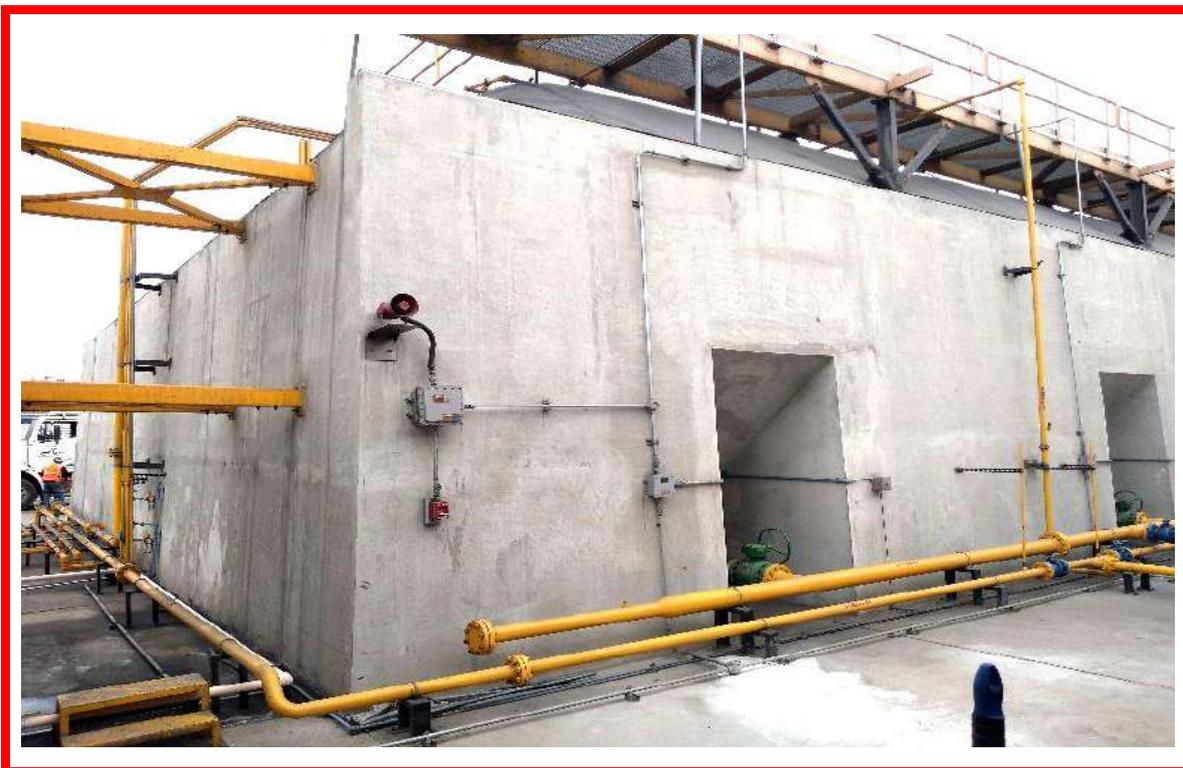
Foto 17. Ubicación de los seis (06) Cilindros estacionarios Horizontales de GLP de 49200 Gls. Cada Uno – Tanques monticulados Con Sistema de Protección Catódica.
