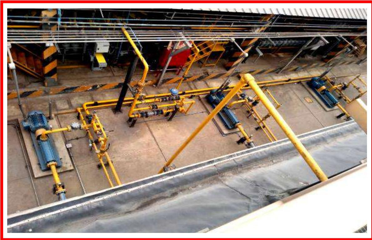
Foto 13. Vista aérea de las tres (03) bombas de GLP en buen estado de conservación y montadas sobre losa de cemento.
