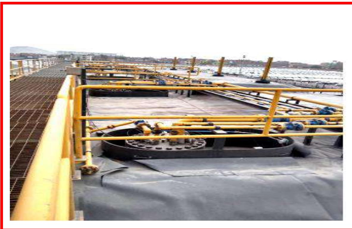
Foto 18. Vista aérea de los seis (06) Cilindros estacionarios Horizontales de GLP de 49200 Gls. Cada Uno.
