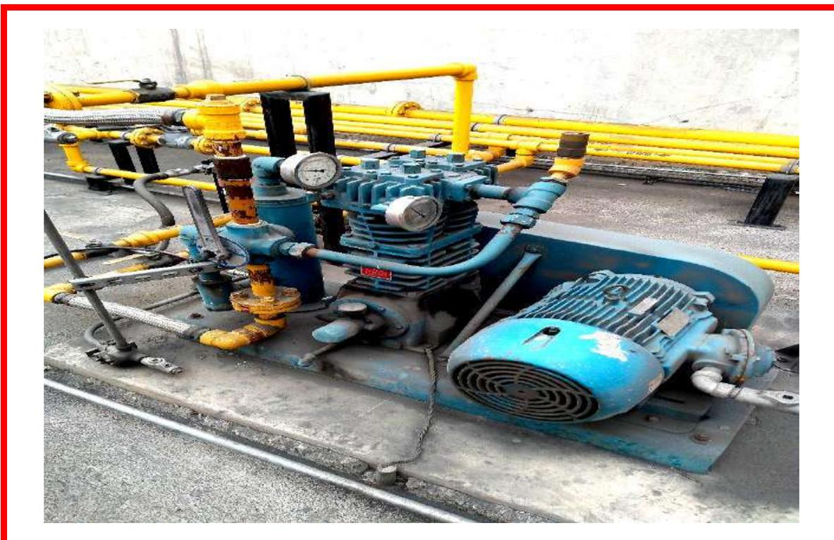
Foto 16. Vista frontal del Compresor utilizado para el Trasiego de GLP.
