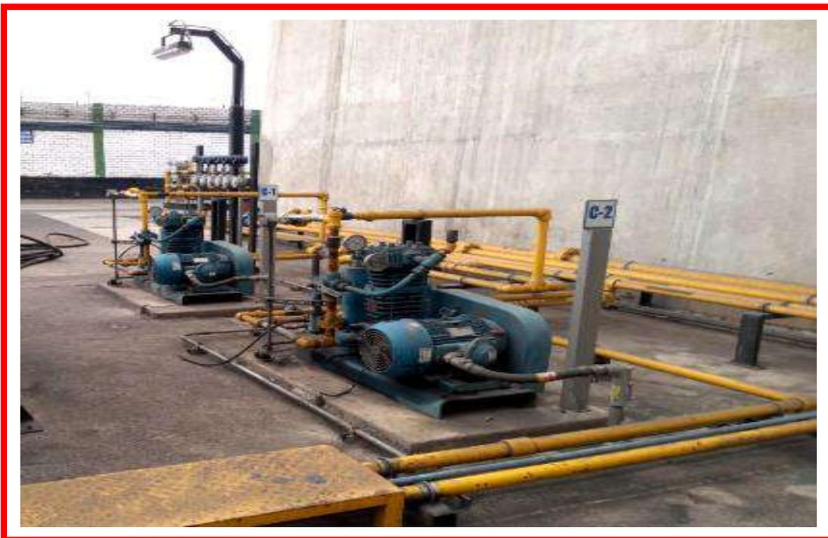
Foto 15. Vista aérea de los dos (02) Compresores utilizados para el Trasiego de GLP.
