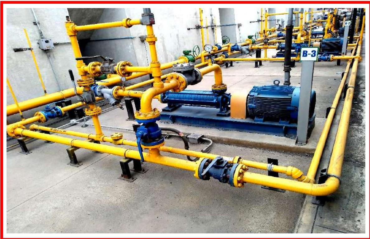
Foto 14. Vista frontal de las bombas de GLP en buen estado de conservación al igual que las tuberías de flujo de Gas Licuado de Petróleo (GLP).
