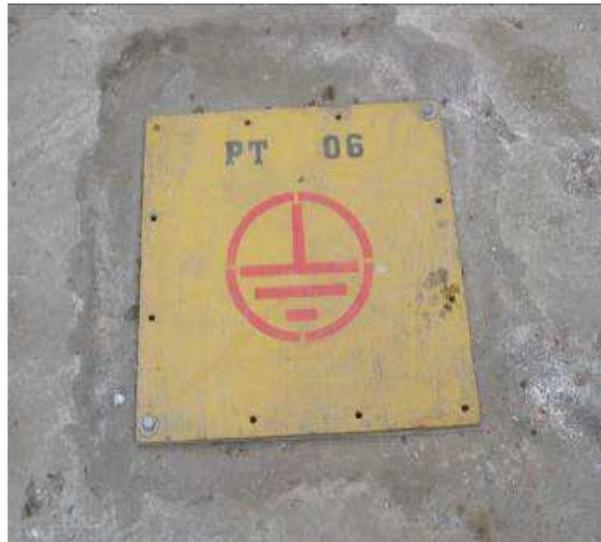
Para mayor seguridad en la planta los tanques de almacenamiento de productos líquidos cuentan con conexión de puesta a tierra para tanques.
