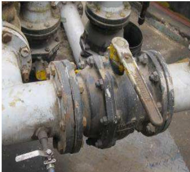
**Figura 34: Válvula de Apertura y Línea de Llenado de Tanques**
